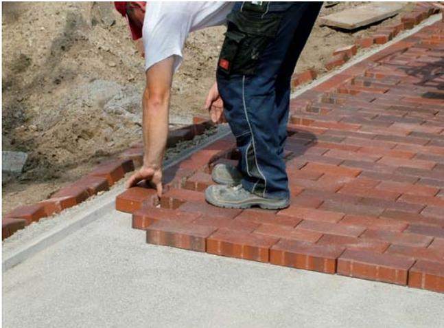
*Abb. 4-8: Ручная укладка клинкерных тротуарных кирпичей*
