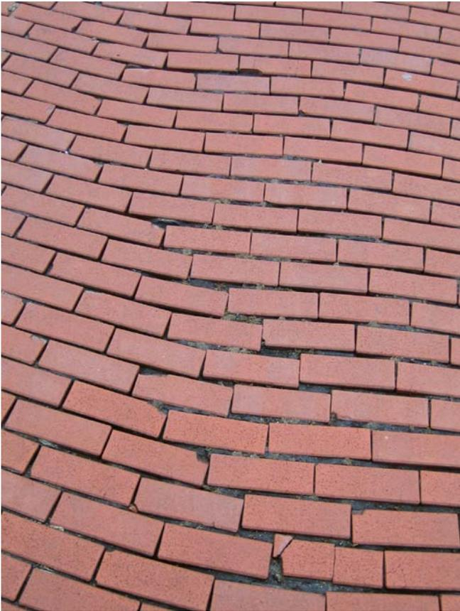
*Abb. 5-1: Недостаточное действие соединения при пустых фугах*
