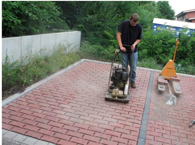
Abb. 4-11: Обработка вибрацией предварительно сметённой поверхности клинкерного тротуарного кирпича
