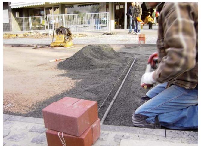
*Abb. 4-6: Стягивание поверхности балласта при использовании предварительно выпрямленной металлической шины*
