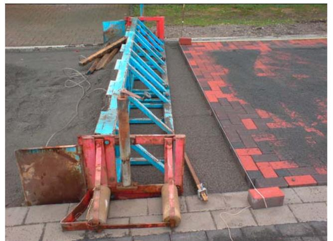
*Abb. 4-7: Стягивание поверхности балласта при использовании лекала*
